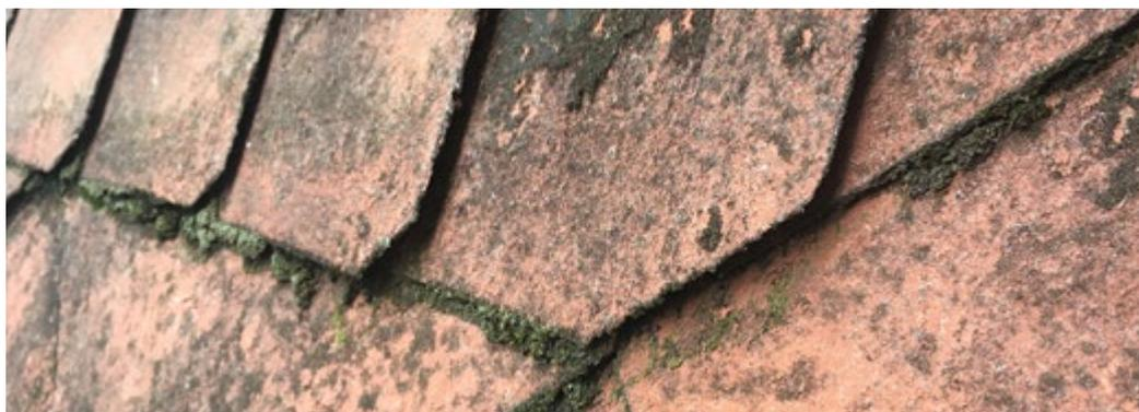
Abbildung 44: Asbesthaltige Dachplatten
